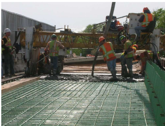
Figura 10 – Execução de ponte com concreto contendo cura interna.
