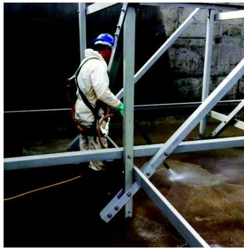
Figura 10 - Lavagem da superfície com hidrotrato 5.800 psi
