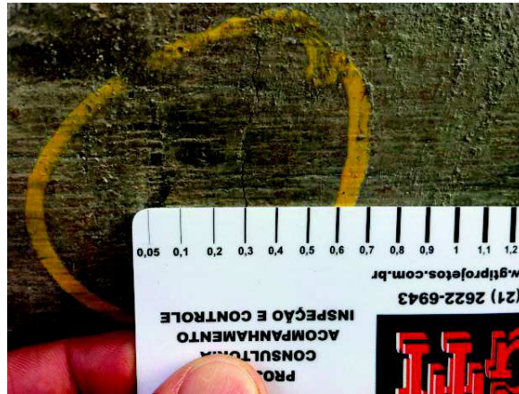
Figura 7 - Mapeamento e medição de fissuras de paramentos verticais
