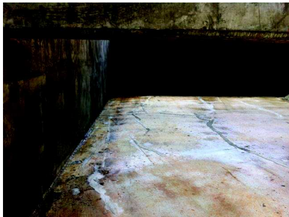
Figura 15 - Silicato bioquimicamente modificado aplicado em toda a ETE
