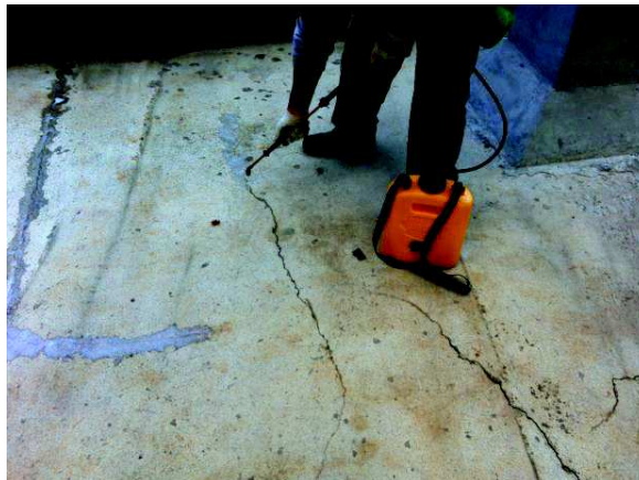
Figura 11 - Aplicação de silicato bioquimicamente modificado nas fissuras de paramentos horizontais.
