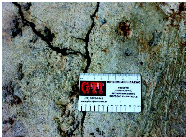
Figura 8 - Mapeamento e medição de fissuras de paramentos horizontais
