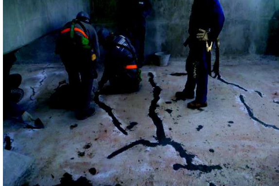
Figura 13 - Grouteamento flúido da fissuras com adição de 1% de cimento cristalizante.
