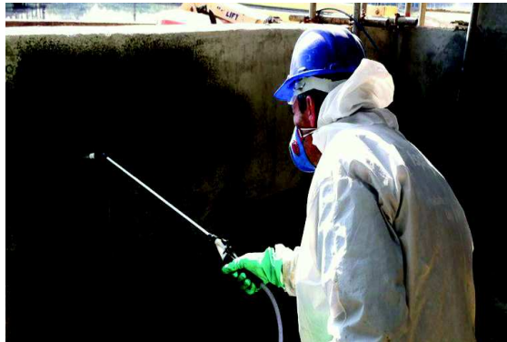
Figura 14 - Aplicação de silicato bioquimicamente modificado em toda a ETE
