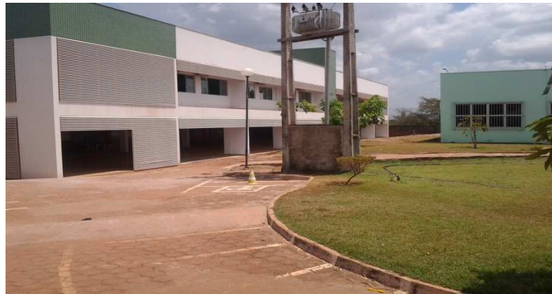
Figura 5 – Fachada externa do bloco das salas de aula
