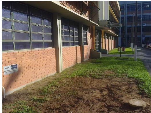
Figura 3.4: Imagem do local de instalação da cisterna
