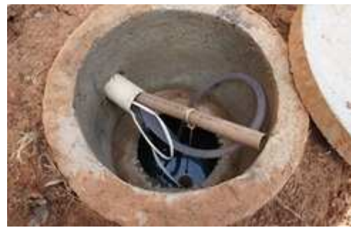
Figura 3.6: Caixa de inspeção da cisterna
