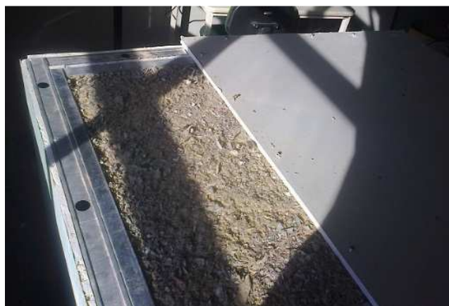
Figura 3.17: Isolante térmico no vão das paredes do AC
