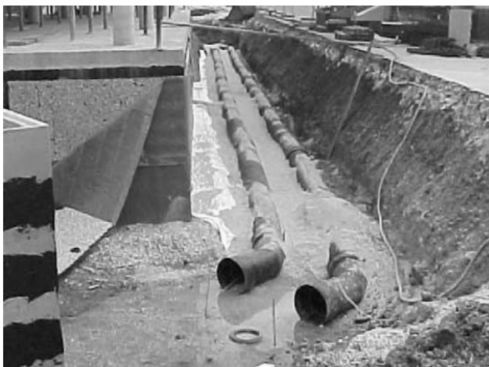
Figura 2.12: Site de construção de um sistema TA em Lamparter/USA. Fonte: Pfafferott, J., 2003
