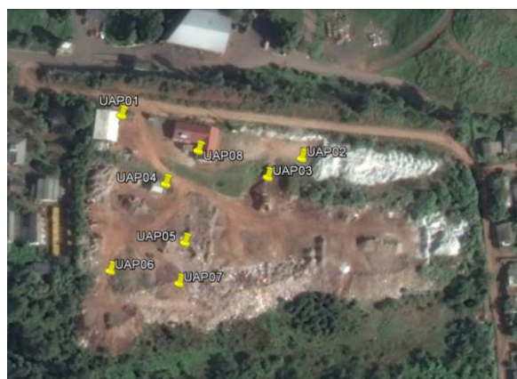
Figura 26 - Localização dos amostradores passivos de SO 2 na usina de resíduos de construção e demolição
