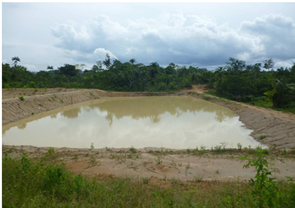
Imagem 31- Tanque de piscicultura construído em São João de Veneza Fonte: o Autor, 2015.
