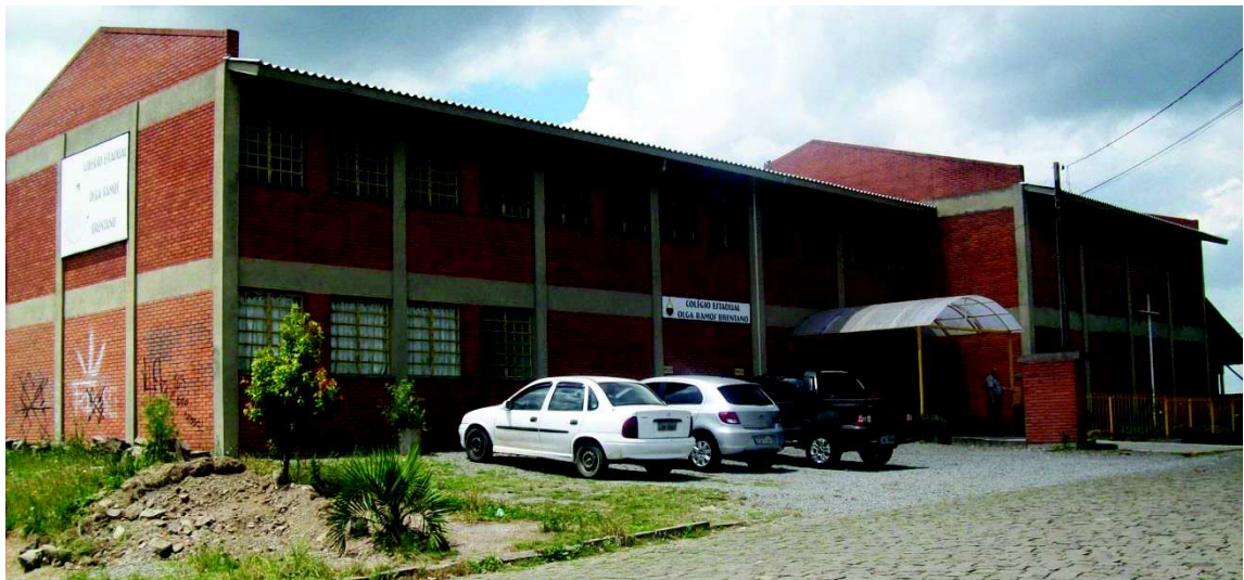
Fotografia 2 - Fachada do Colégio Estadual Olga Ramos Brentano
