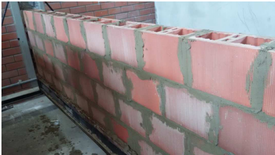
Figura 9 – Execução da parede de alvenaria.
