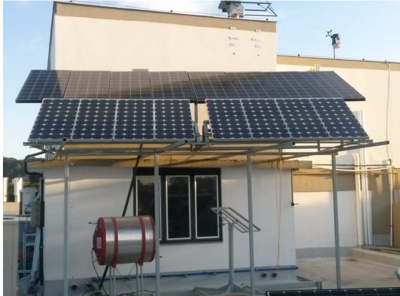
Figura 3.2- Painéis FV com duas tecnologias de módulos FV, silício mono e multicristalino.
