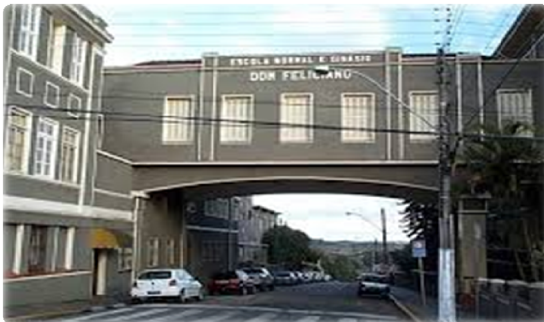
FOTO 2 – Fotografia da passarela do Colégio Dom Feliciano sobre a Avenida
