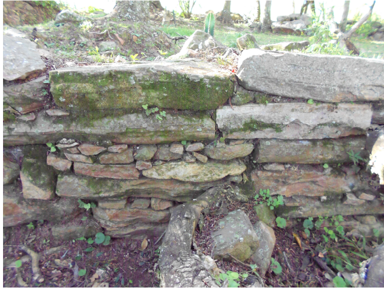
Fotografia 7: Meio da parede de fundo do espaço 1.
