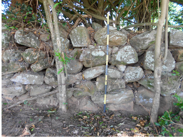
Fotografia 47: Construção da primeira cerca de pedra.
