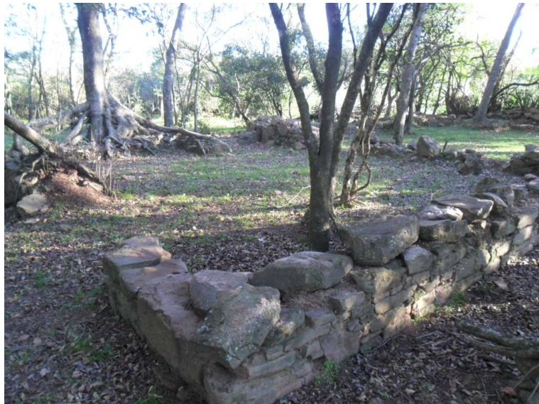
Fotografia 2: Canto A mostrando o encontro da parede da frente com a lateral direita do espaço 2.
