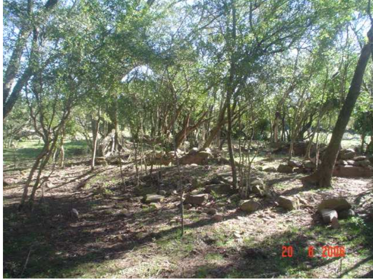
Fotografia 1: Vista geral das ruínas do prédio.
