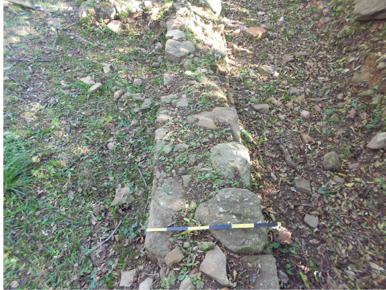
Fotografia 5: Parede lateral esquerda do espaço 1.
