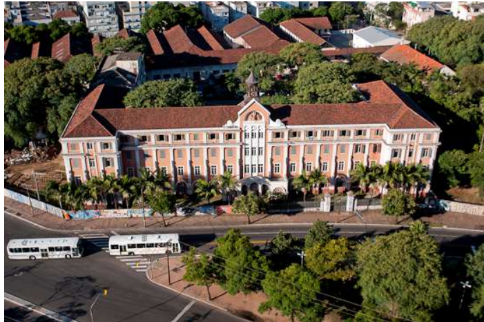
Figura 12 – Vista aérea da Fundação Pão dos Pobres
