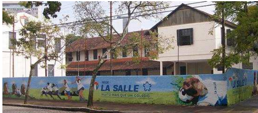
Figura 11 – Colégio La Salle Pão dos Pobres
