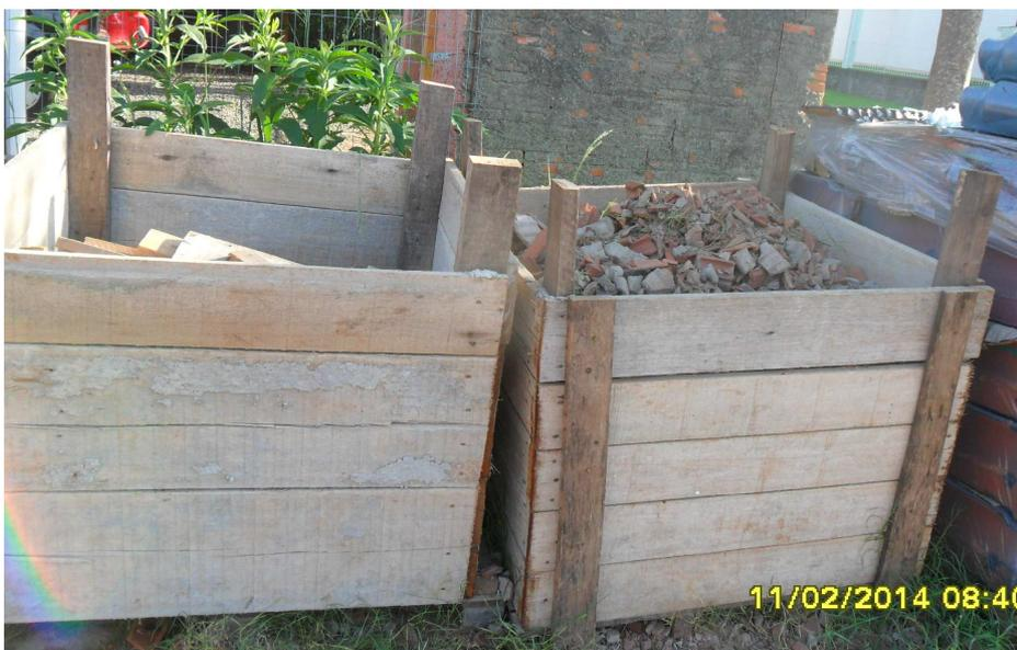
Figura 11: Caixa confeccionada para acondicionamento do RCD.
