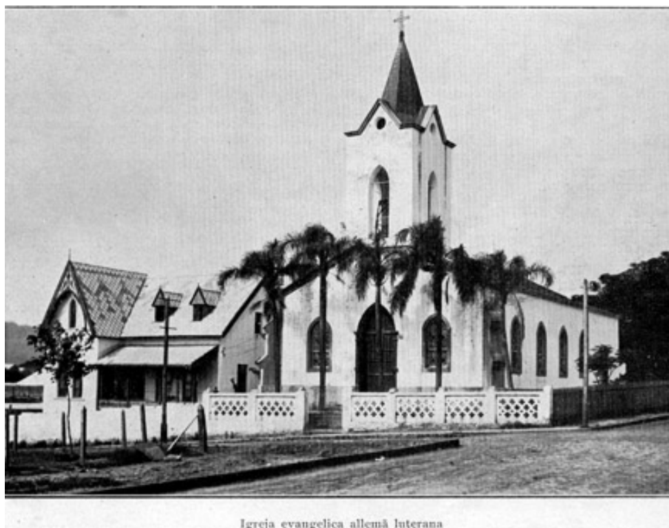
Ilustração 1 - Igreja Evangélica de Confissão Luterana localizada à Rua Barão do Triunfo, Santa Maria. O prédio foi inaugurado em 1873 e a torre foi concluída em 1887, mas a lei imperial permitiu que os sinos das Igrejas acatólicas pudessem badalar somente a partir de 1888 (Fonte: DAISSON, Augusto (Org.). Revista do Centenário de Santa Maria . Santa Maria: Globo, 1914).
