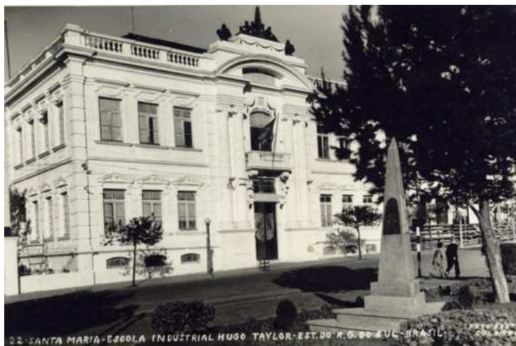
Ilustração 37 – Parte da fachada da antiga Escola de Artes e Ofícios “Hugo Taylor” (Seção masculina), localizada na Avenida Rio Branco, em Santa Maria (Fonte: Casa de Memória Edmundo Cardoso)
