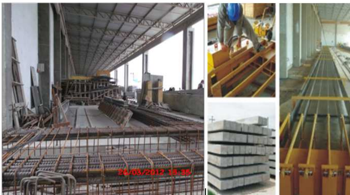
Figura 6 Empresa de Pré-Moldados, localizada em um galpão interno da CDC.
