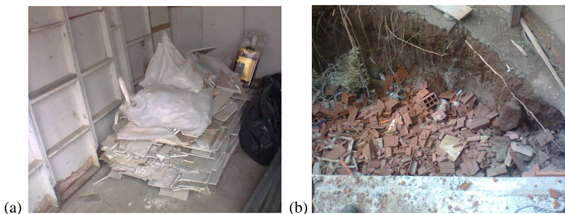
Figura 11 – (a) Armazenamento de resíduos de gesso em baias (b) resíduos Classe A sendo reaproveitados como aterro em um vão
