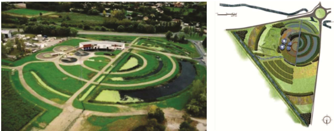
Figura 18 – Estação de tratamento de Honfleur.
