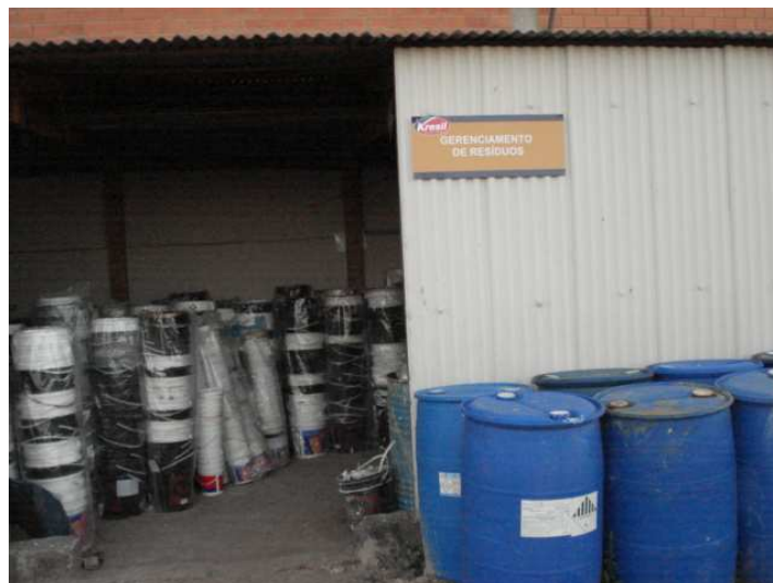
Figura 31– Central de Resíduos.
