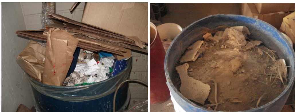
Figura 42 – Não segregação de resíduos para correta destinação.
