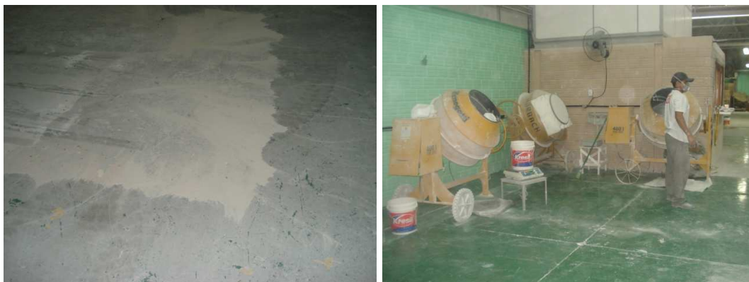
Figura 40 – (A) Antes: piso sem pintura.(B) Depois: piso liso.
