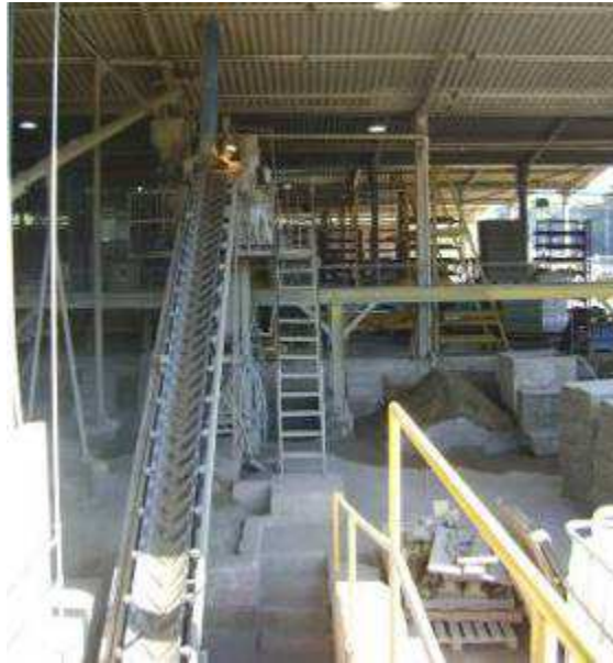
Figura 4 - Esteira de carregamento de agregados.
