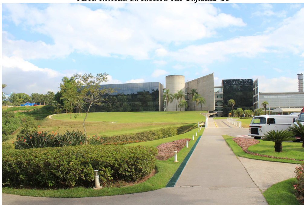
Área externa da fábrica em Cajamar-SP
