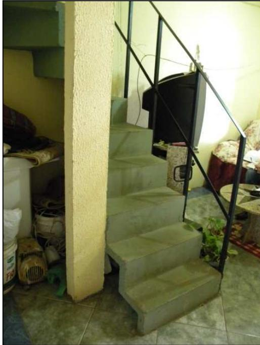
Figura 54: Escada de concreto dimensões insuficientes
