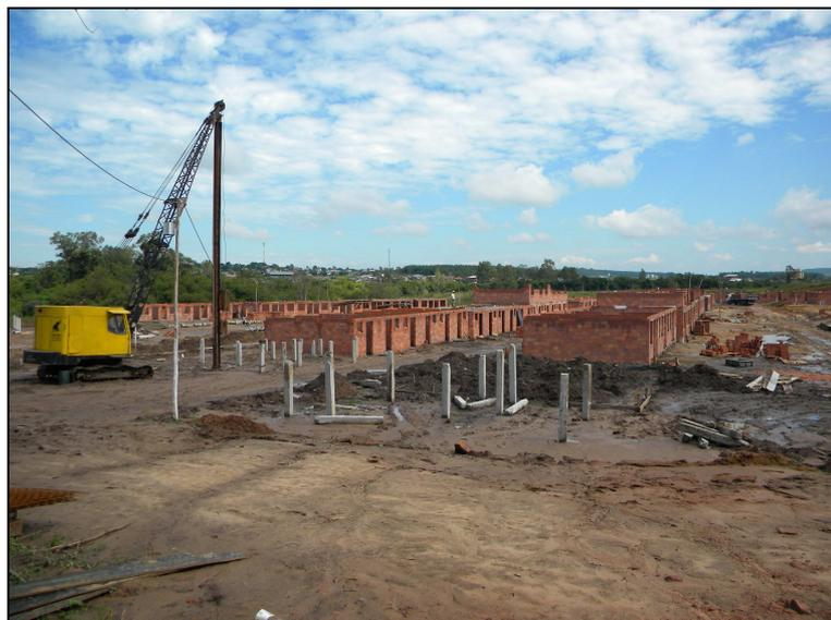
Figura 22: Construção pré-moldada e artesanal – Condomínio Germano Arduino Toniolo
