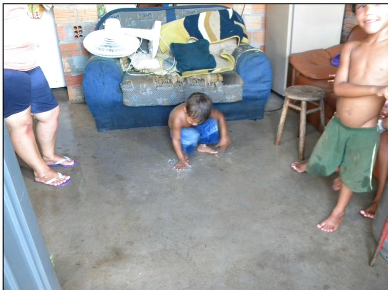
Figura 44: Piso desempenado com poças d'água
