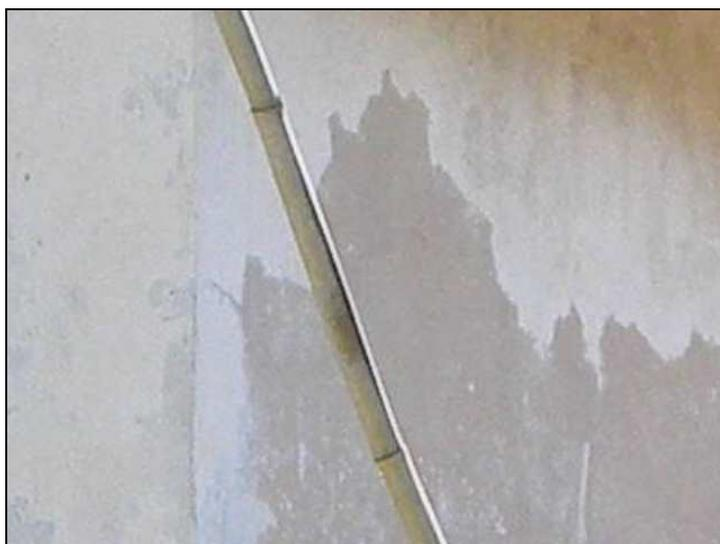
Figura 63: Manchas de umidade na fachada
