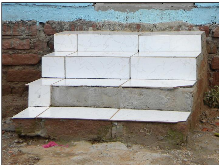
Figura 62: Degraus de acesso com cerâmica
