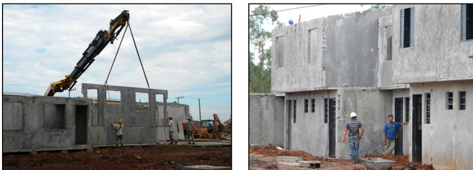
Figura 16: Montagem de painéis pré-moldados e arremates artesanais – Padre Orestes
