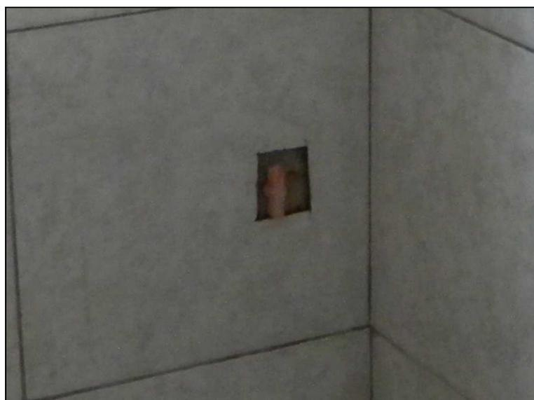
Figura 53: Registro enterrado na parede
