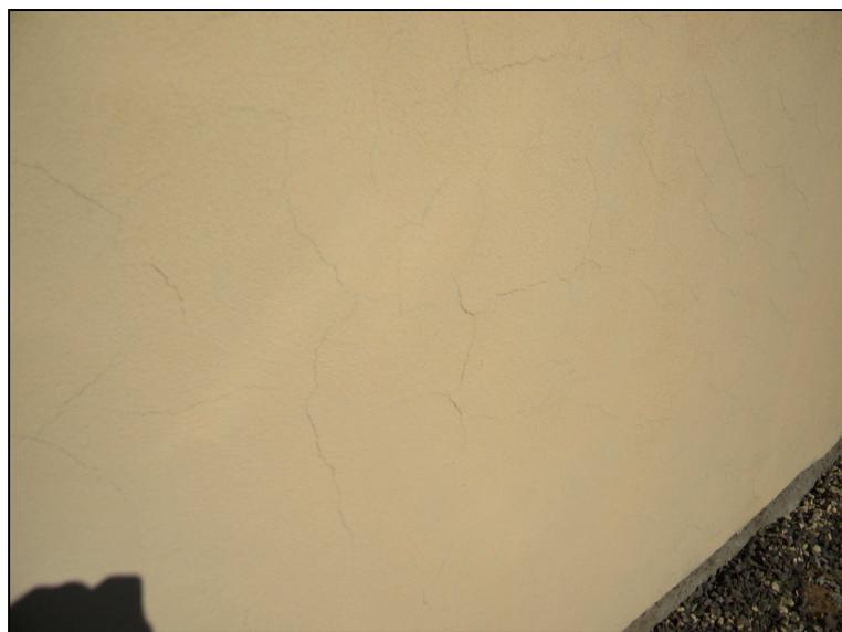
Figura 60: Trincas externas - Retração da argamassa
