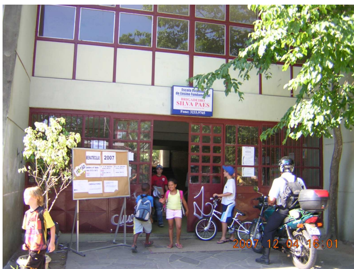
Fachada externa da E. E. E. Fundamental Brigadeiro Silva Paes
