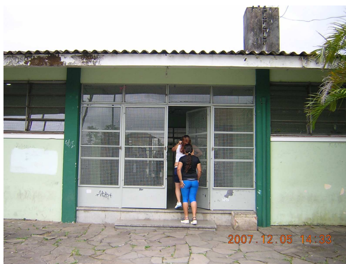
Fachada externa do Colégio Estadual Odila Gay da Fonseca
