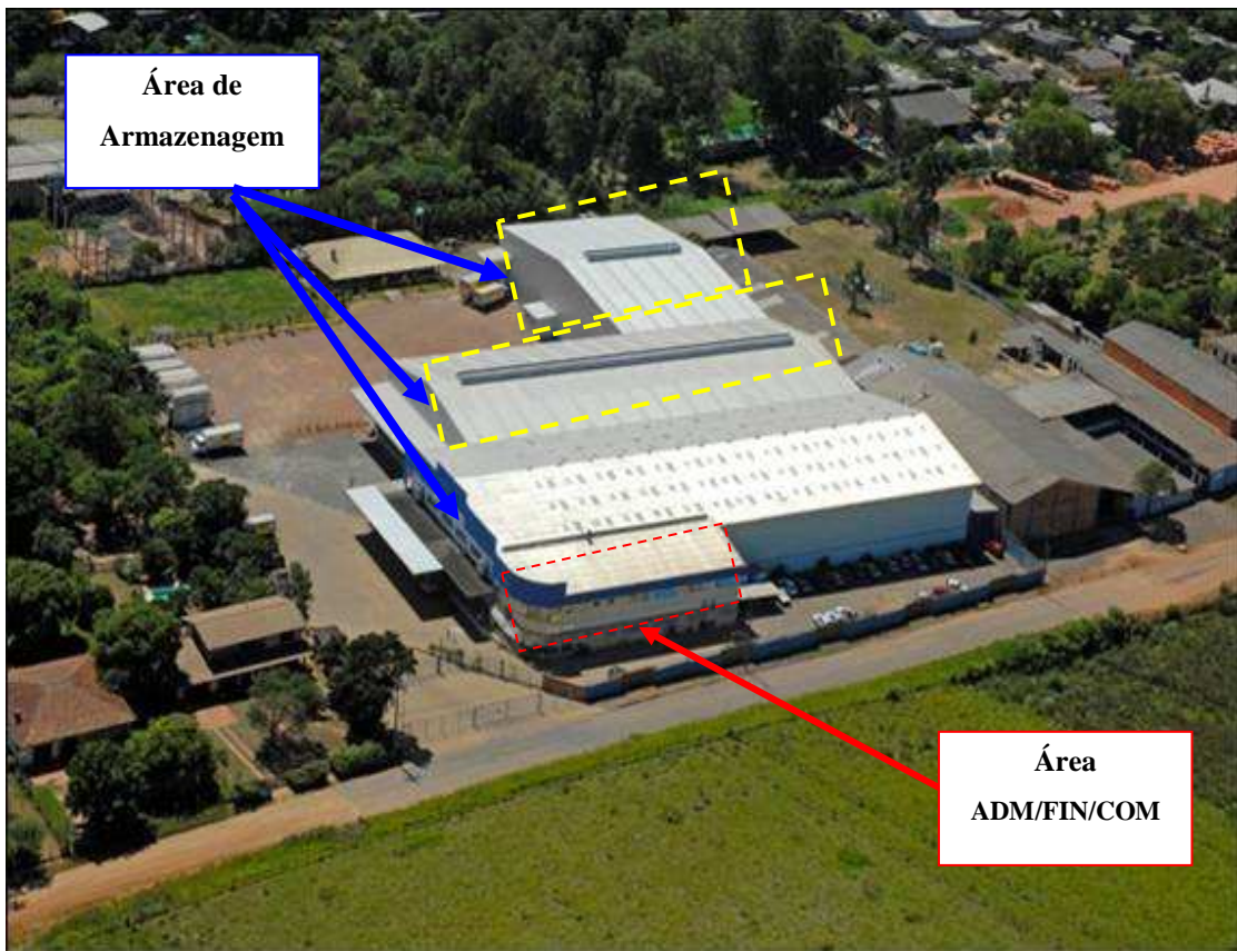
Figura 23: Centro de Distribuição/ Área de Armazenagem e Administrativa Fonte: Adaptado da Empresa Alfa
