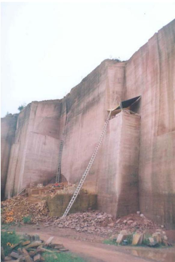
**Figura 7.13** A Unidade Hidroestratigráfica Botucatu caracteriza-se por sua uniformidade litológica conforme se pode ver nos afloramentos, feição confirmada pelos perfis geofísicos de poços e sondagens. Este afloramento com aspecto de muralha, pertence a uma pedreira no município de Santo Antônio da Patrulha.
