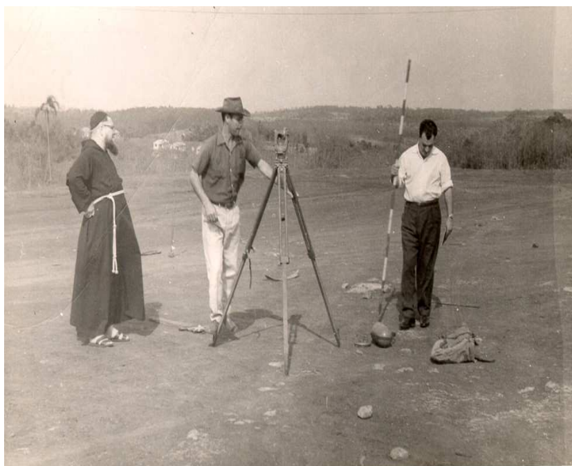
FIGURA 35 - Nivelamento do terreno para a construção da FAFI
