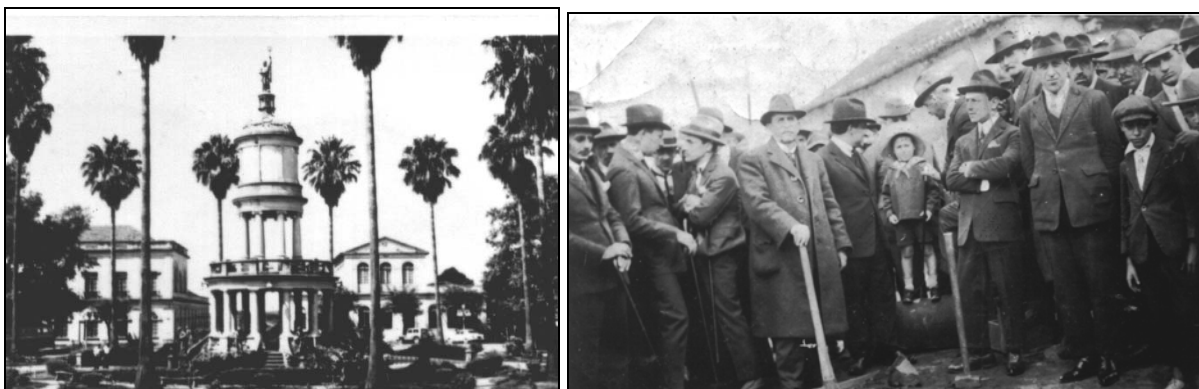
Figuras 53 e 54 – Chateau d'Eau e início das obras de instalação da rede de esgoto, vendo-se o intendente, capitão Francisco Fontoura Nogueira da Gama, de sobretudo, com uma picareta na mão, fevereiro de 1924. Fonte: Museu Histórico Municipal de Cachoeira do Sul
