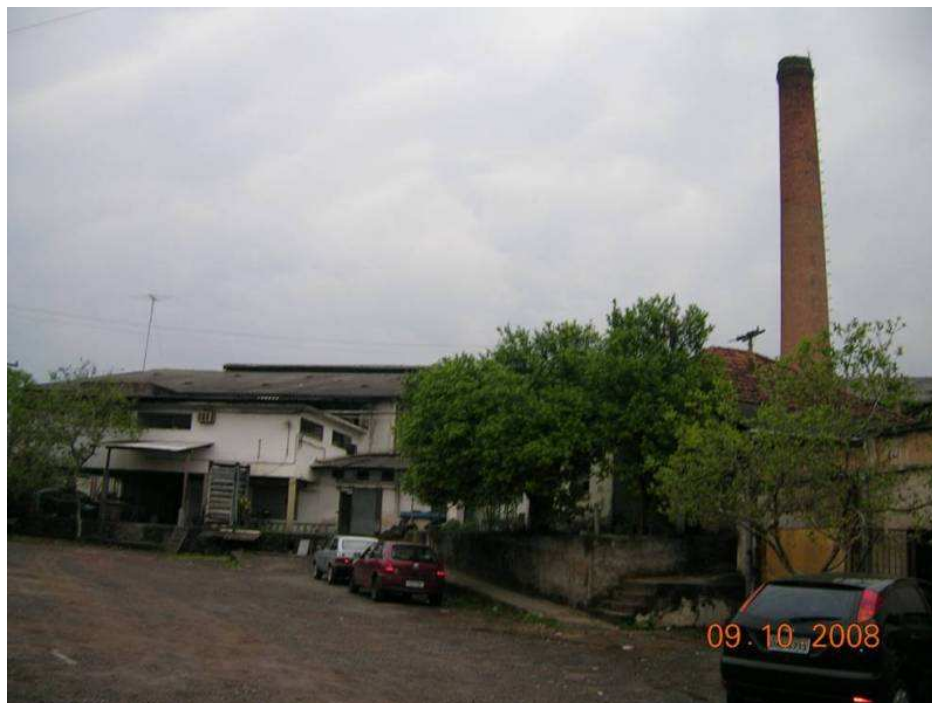
Figura 2. Vista do Pátio Interno da COOPEREI
