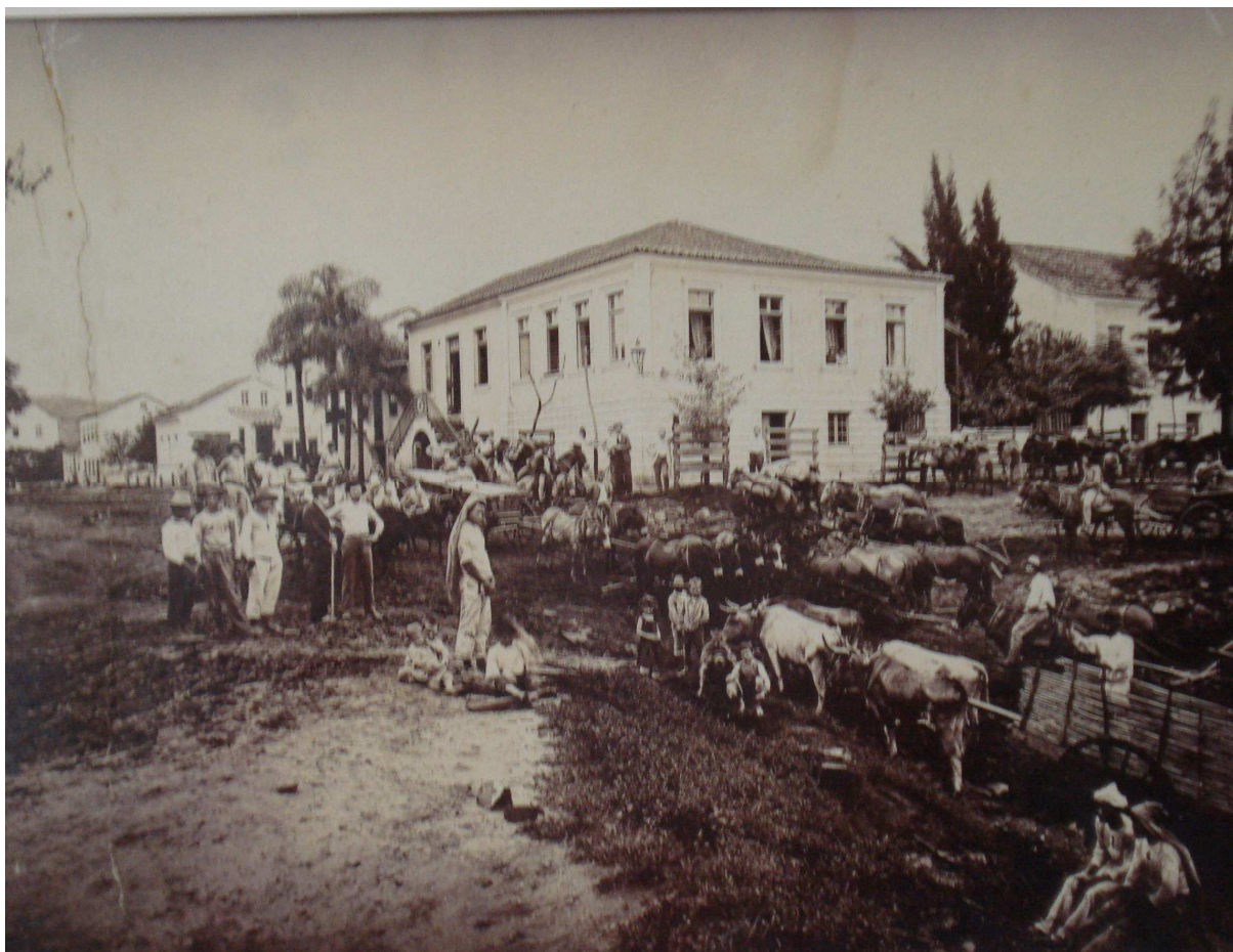
Figura 5 - Região do cais do porto, junto à vila de São Sebastião do Caí, sede municipal 1
