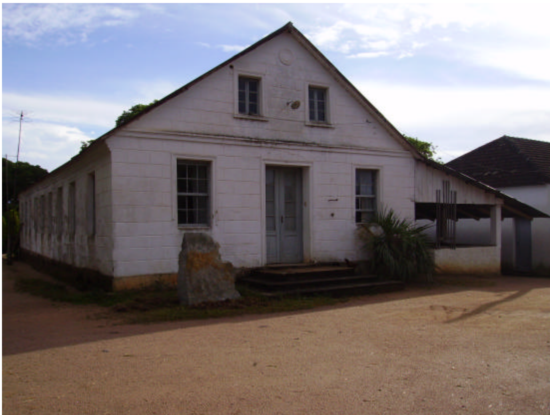
Antiga casa da Família Rheingantz, já com a pedra que abrigará uma placa em homenagem ao sesquicentenário de colonização alemã, em São Lourenço do Sul.
