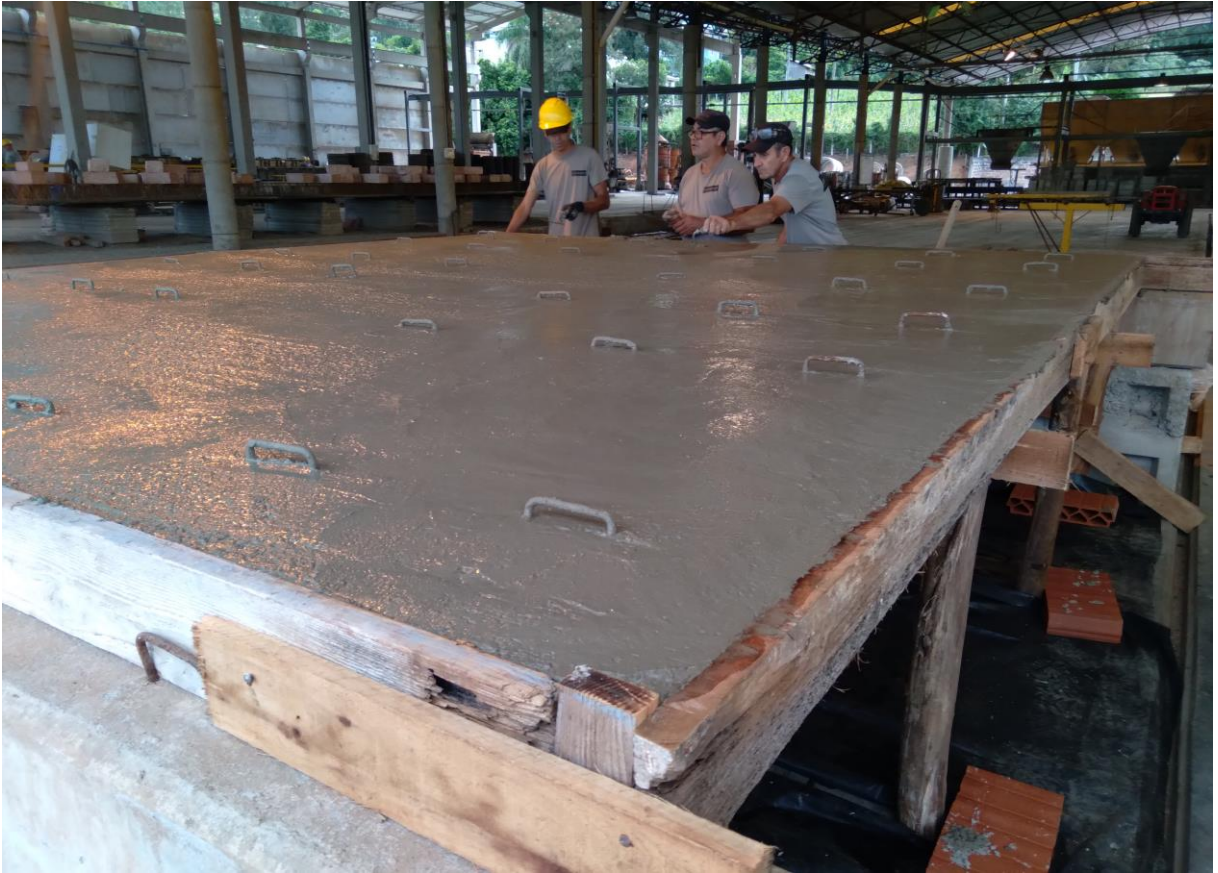
Fotografia 5 – Conclusão da concretagem da primeira camada da capa de concreto
