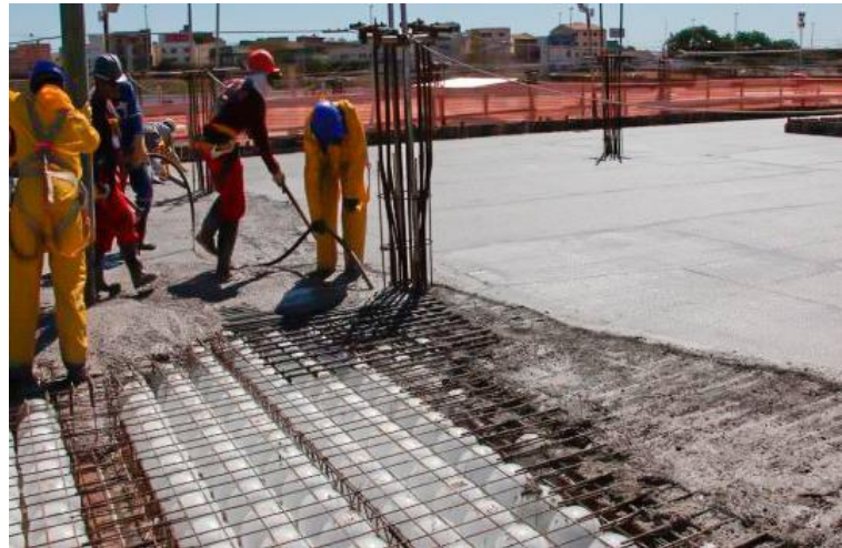
Figura 4 – Laje Bubbledeck
