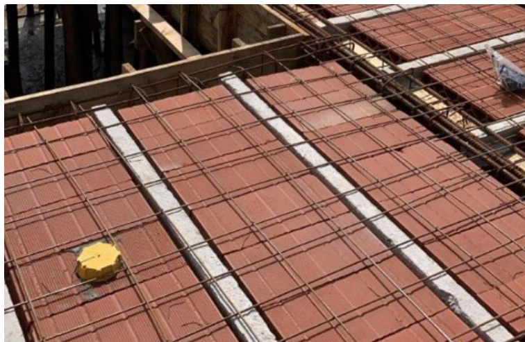
Figura 8 – Laje de vigota protendida
