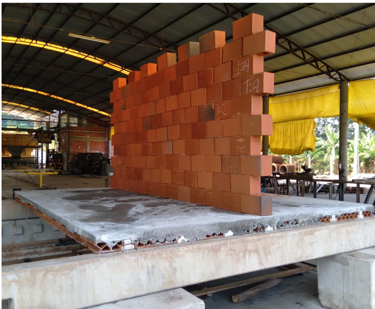
Fotografia 7 – Alvenaria de blocos concluída
