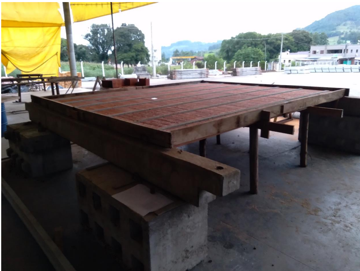
Fotografia 2 – Escoramento, fôrmas e vigotas e tabelas cerâmicas montadas
