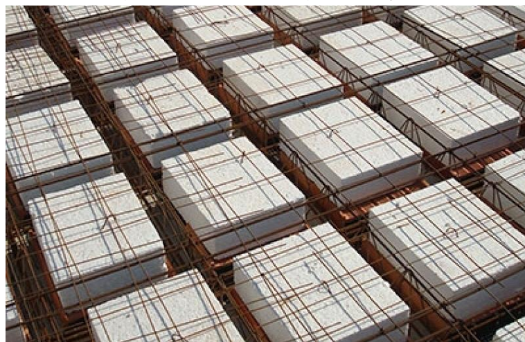
Figura 5 – Laje de vigota treliçada
