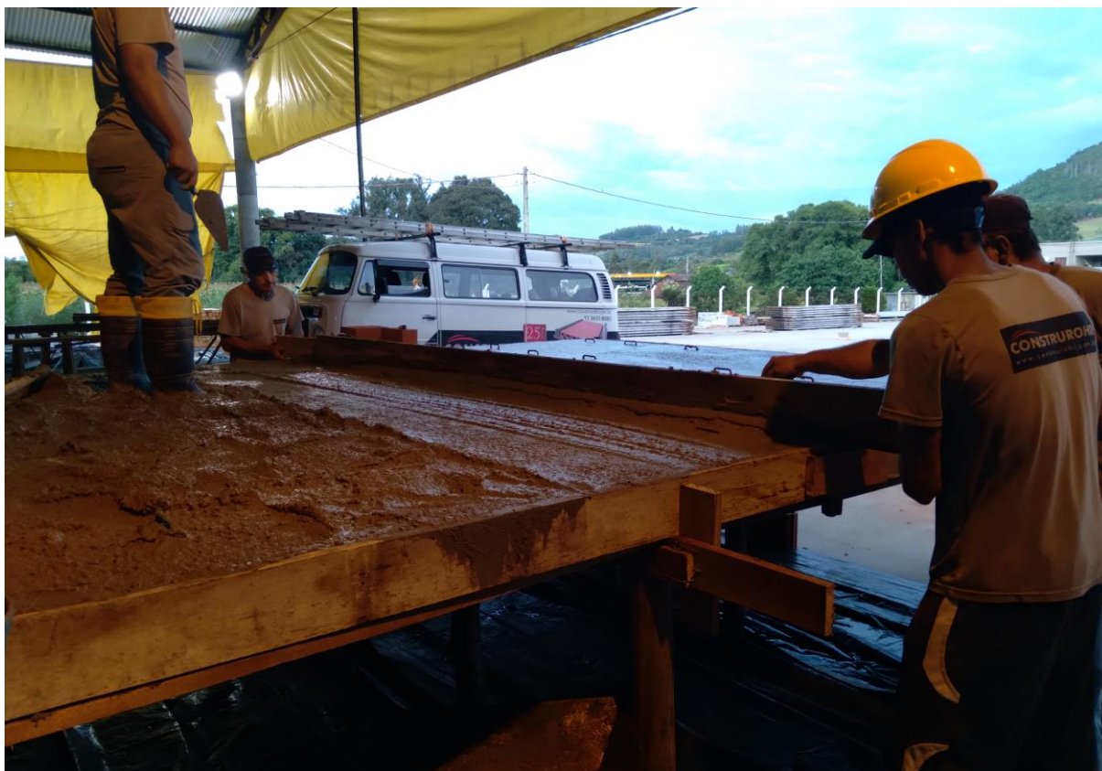
Fotografia 4 – Concretagem da primeira camada da capa de concreto
