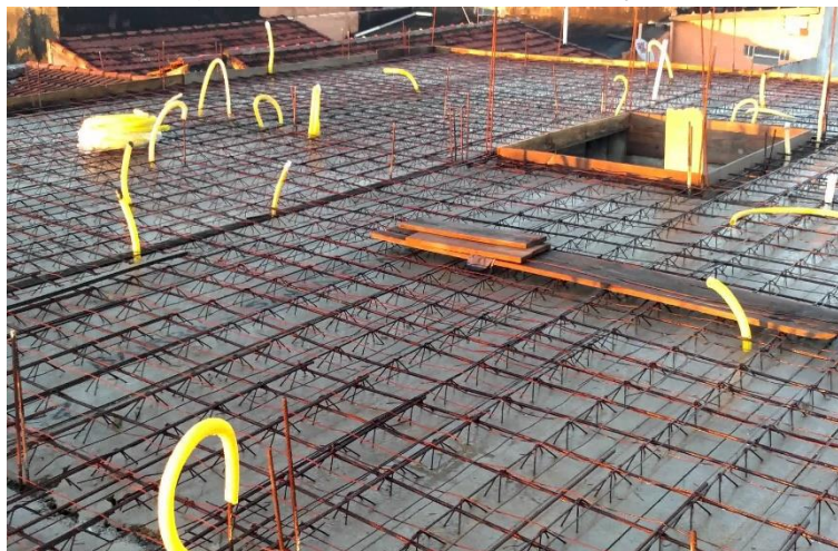
Figura 3 – Laje de painel treliçado
