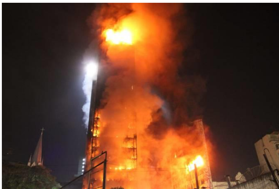
Figura 2 – Incêndio no Edifício Wilton Paes de Almeida
