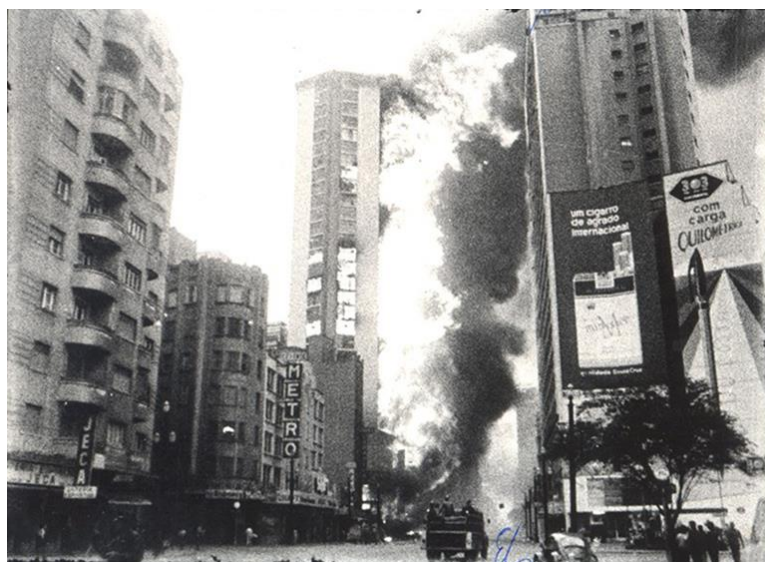
Figura 1 – Fachada do Edifício Andraus em chamas
