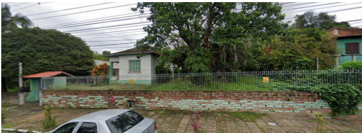
Figura 10 - Terreno onde está sendo construído o edifício
