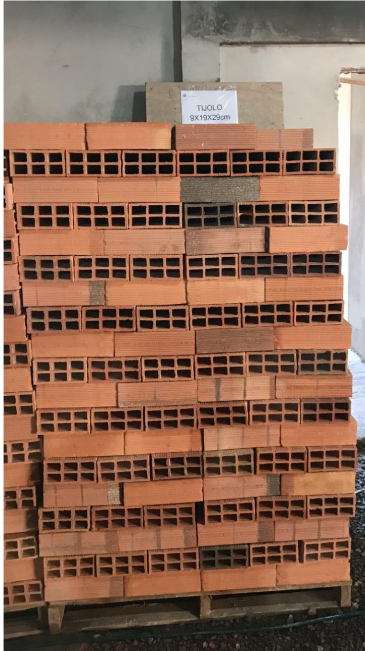
Figura 155 - Armazenamento de blocos cerâmicos
