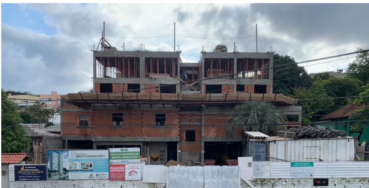
Figura 11 - Obra em outubro/2021
