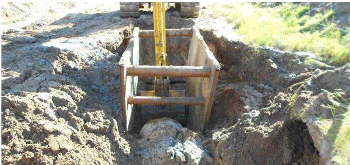
Figura 20 – Blindagem metálica em uso como escoramento de vala
