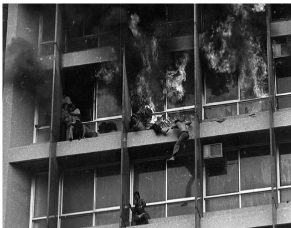
Figura 3 - Prédio Joelma em Chamas
