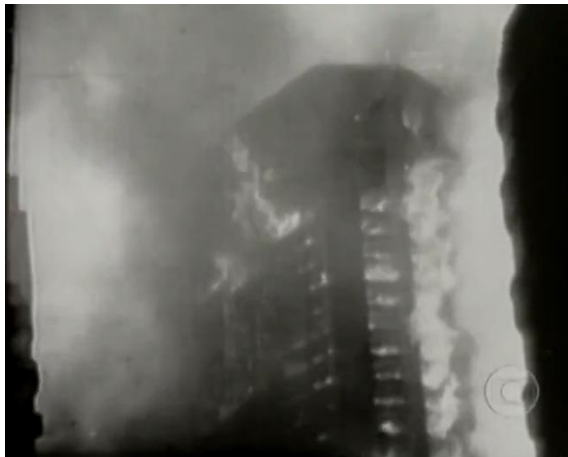
Figura 2 - Edificação Andraus em Chamas
