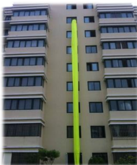
Figura 8 - Escape Chute System em Operação
