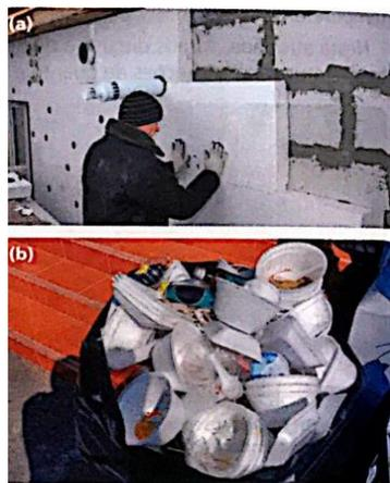
Figura 6.15 – a) O isopor, por ser um bom isolante térmico, é uma opção barata para garantir o conforto térmico em construções. b) Seu uso indiscriminado e o descarte inadequado geram resíduos que contribuem para a poluição de mares e oceanos.
