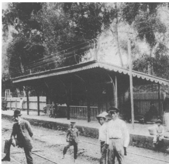
Fotografia 5 – Estação Capão das Canoas
