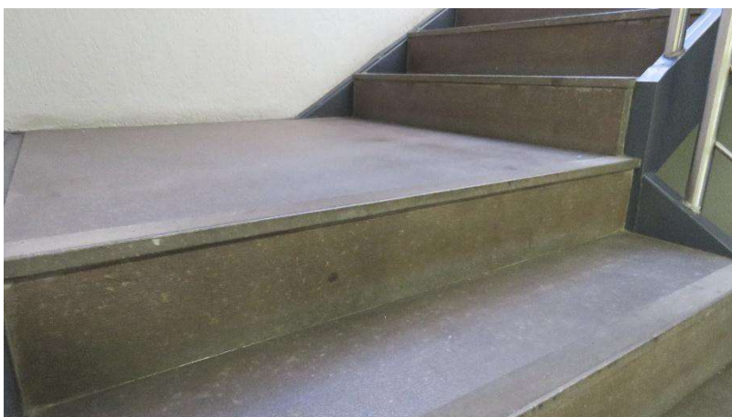
Figura 60 - Ausência de fita de contraste no espelho e no piso de cada degrau
