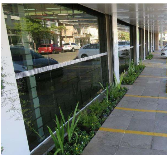
Figura 47 - Faixa sinalizadora em fachadas de vidro
