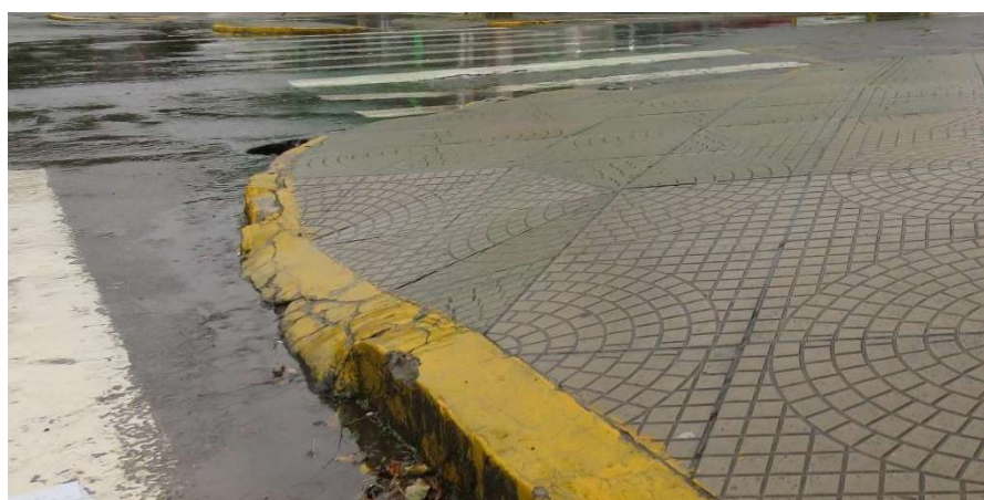
Figura 18 - Rebaixo da calçada
