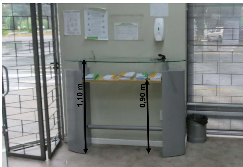
Figura 26 - Bancada para o preenchimento de envelopes para depósito
