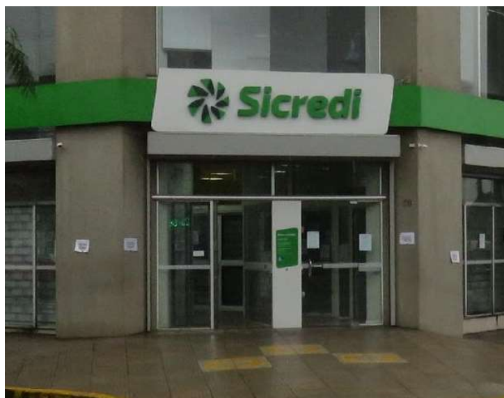
Figura 20 - Entrada principal da edificação
