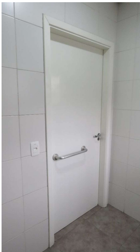
Figura 66 - Puxador horizontal na face interna da porta
