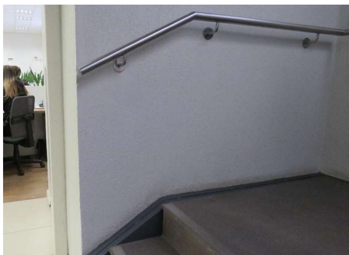
Figura 59 - Corrimãos terminam juntamente com a escada
