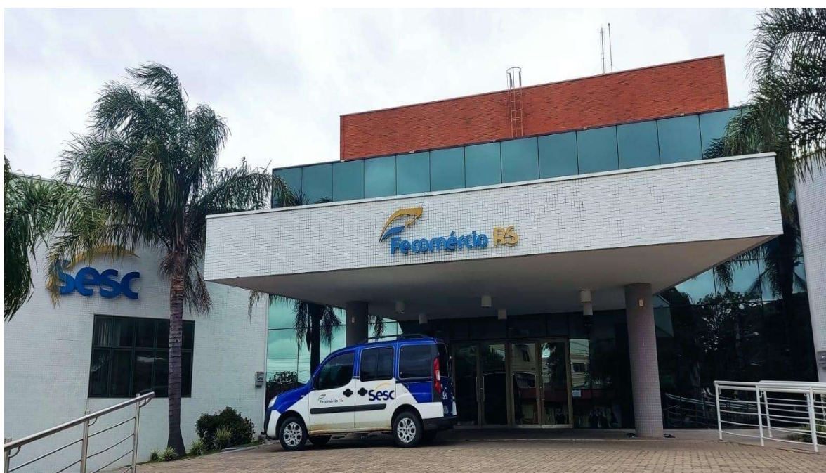
Fotografia 11 - Fachada da Unidade Operacional do SESC/RS Camaquã
