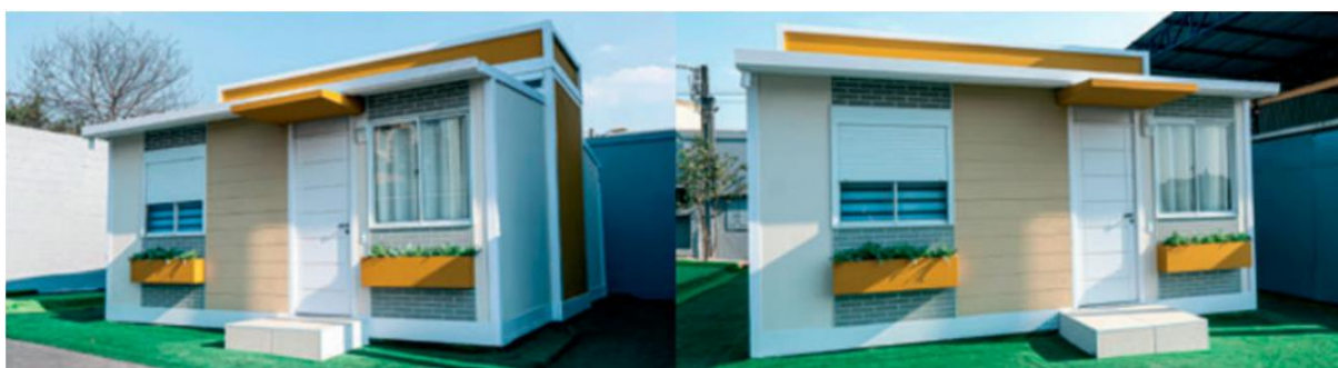
Figura 8 – Unidade Habitacional confeccionada em UHPC pela empresa New House
