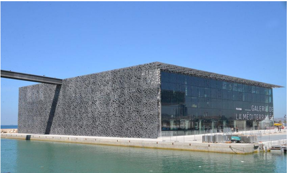
Figura 6 – Estrutura da fachada, cobertura e passarela em UHPC do MUCEM.
