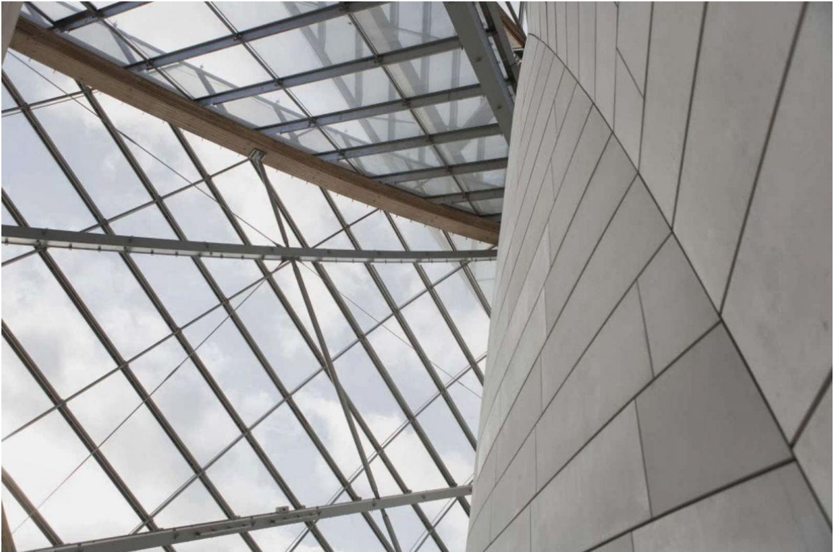
Figura 5 – Painéis de UHPC da Fundação Louis Vuitton.
