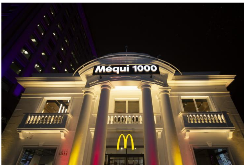
Figura 18 – Fachada do Méqui 1000, localizado na Av. Paulista em São Paulo
