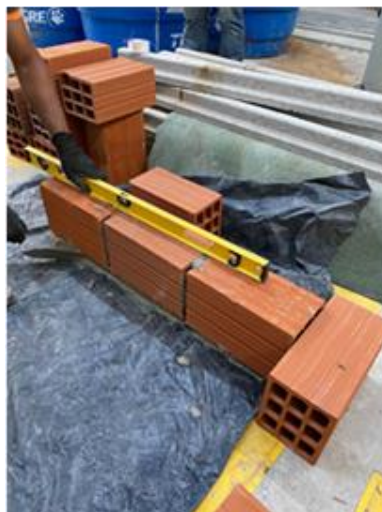
Figura 48 – Assentamento dos Blocos cerâmicos
