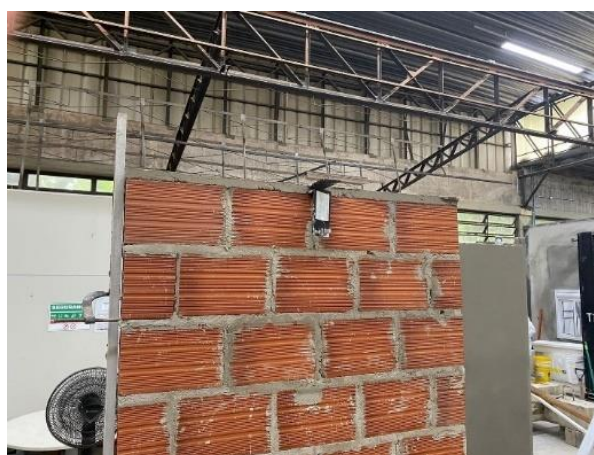
Figura 54 - Encunhamento da parede P5E-ind
