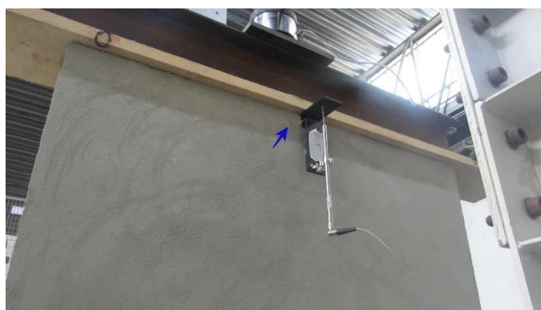
Figura 67 – Primeiro dano, fissura a 76,39kN
