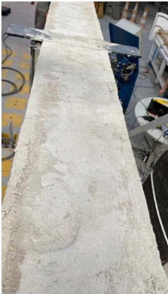
Topo da parede
