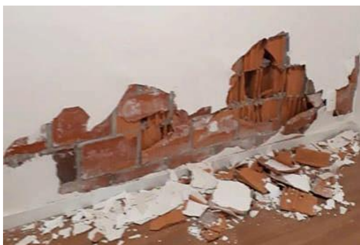
Figura 15 – Deformação transversal da argamassa de assentamento
