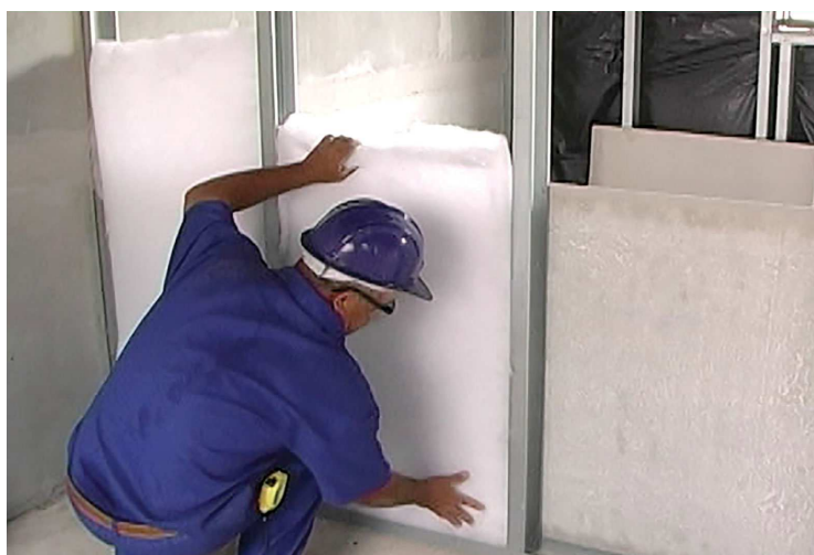
Figura 9 - Lã de PET sendo utilizada como preenchimento de parede leve
