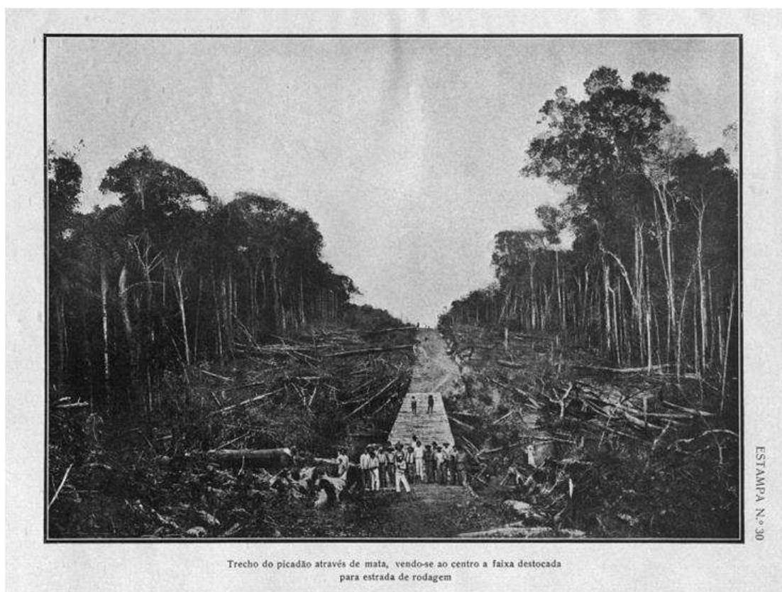
Figura 10 – Picadão para instalação das Linhas Telegráficas 53 (1907-1915)
