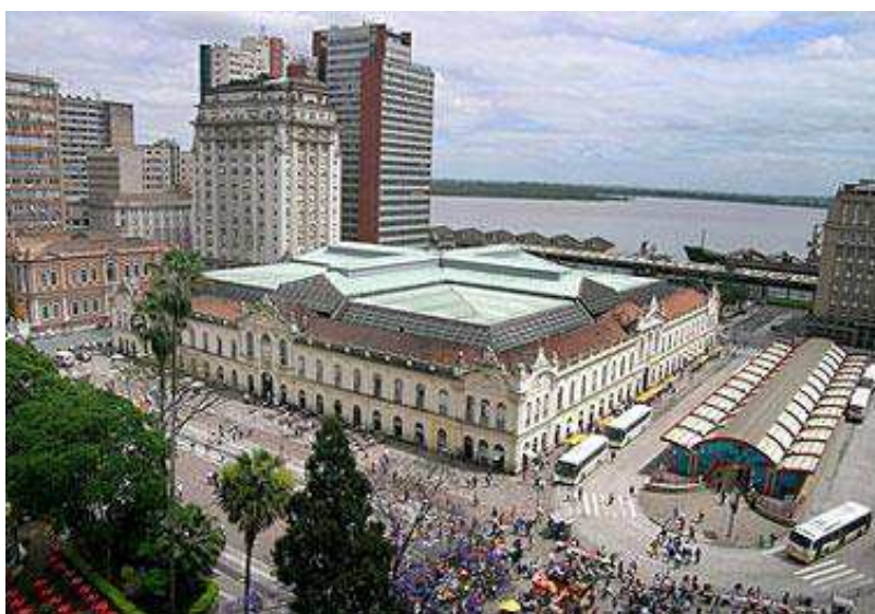
Figura 9 – Vista aérea do MPPoa a partir de esquina da Praça Glênio Peres
