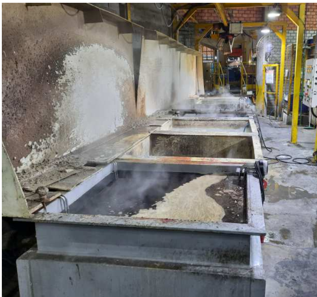
Figura 59 - Linha de tratamento de superfícies – Viemar Automotive
