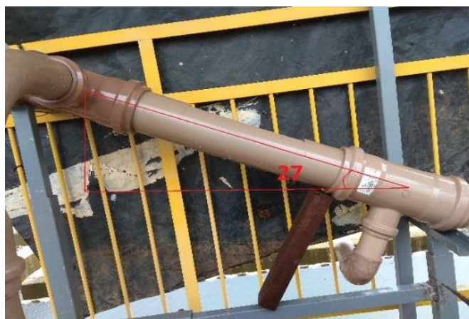
Figura 32: Ajuste do ângulo inclinação de 27° do conjunto
