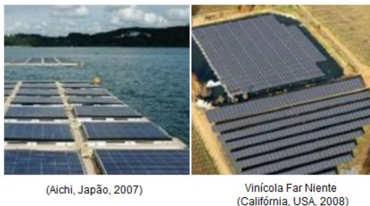
Figura 10 – Primeiros projetos fotovoltaicos flutuantes
