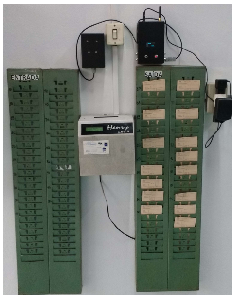
Figura 83 - Nó e leitor RFID instalados no relógio ponto
