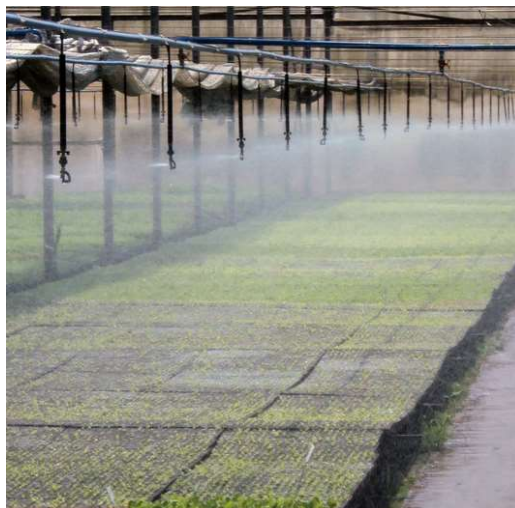
Figura 9 - Microaspersores montados na posição invertida sobre as bandejas em uma estufa
