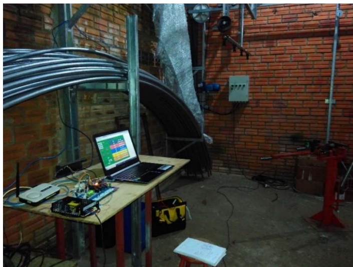
Figura 86 - Dispositivos interligados junto à estrutura da barra irrigadora
