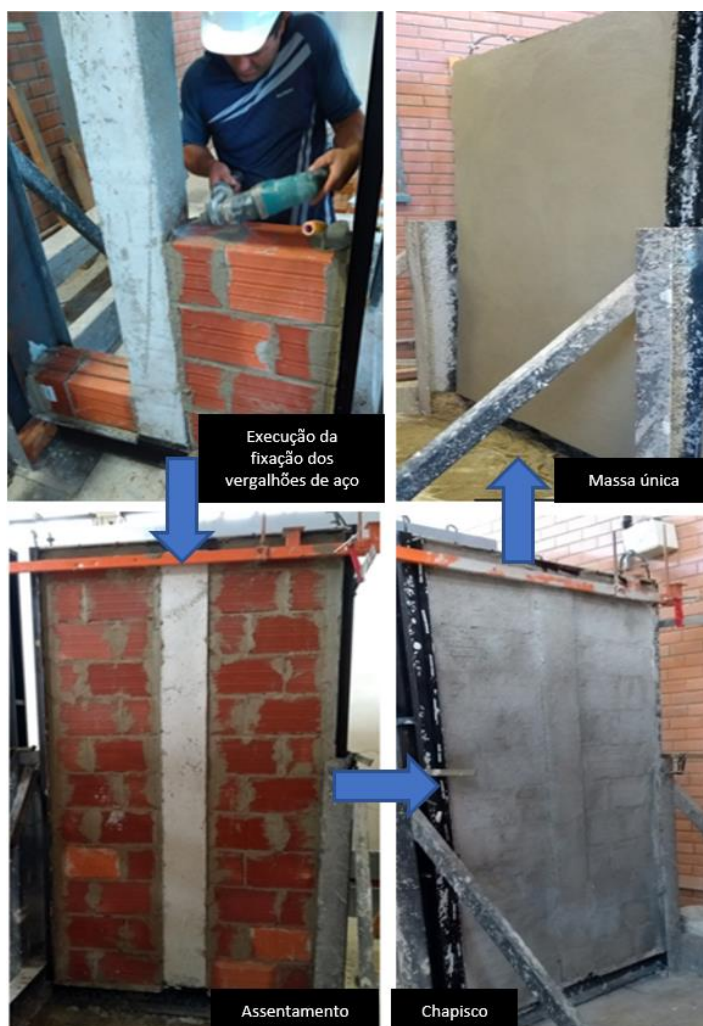
Figura 11 – Etapas construtivas da parede 1 (P1) “ferro cabelo”.
