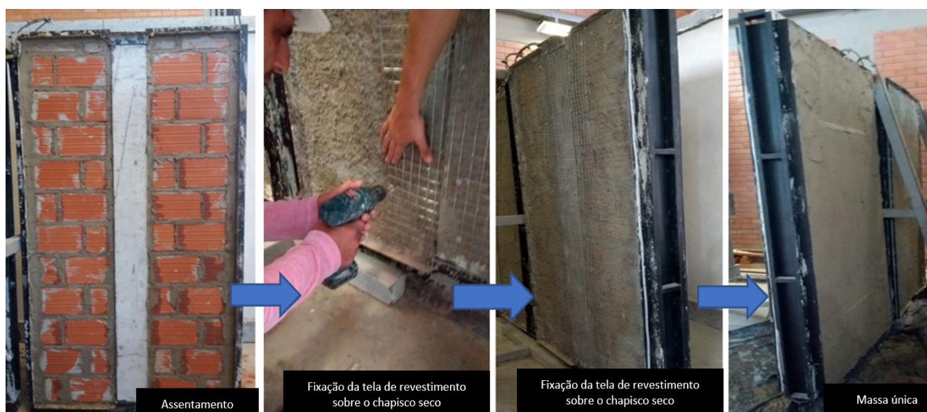
Figura 14 – Etapas construtivas da parede 4 (P4) “tela revestimento”.
