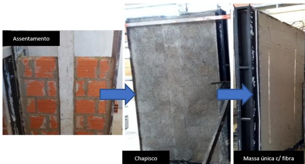
Figura 12 – Etapas construtivas da parede 2 (P2) “fibra PP”.
