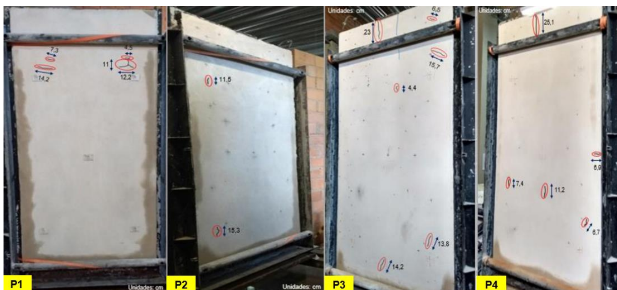
Figura 41– Mapeamento das fissuras nas amostras (face exposta ao ensaio)
