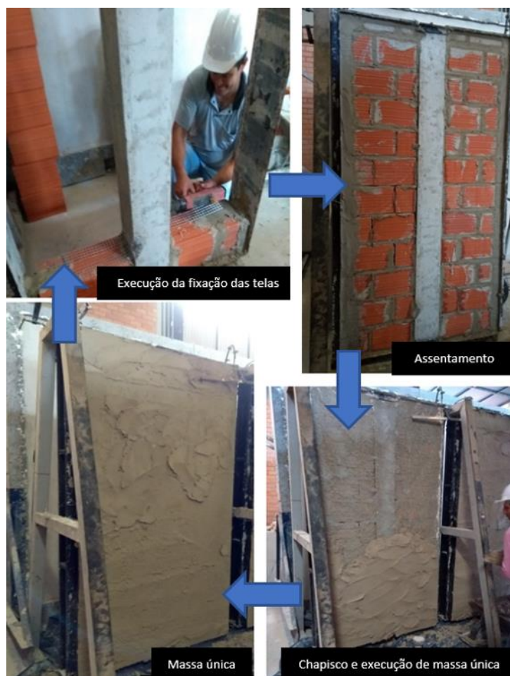
Figura 13– Etapas construtivas da parede 3 (P3) “tela assentamento”
